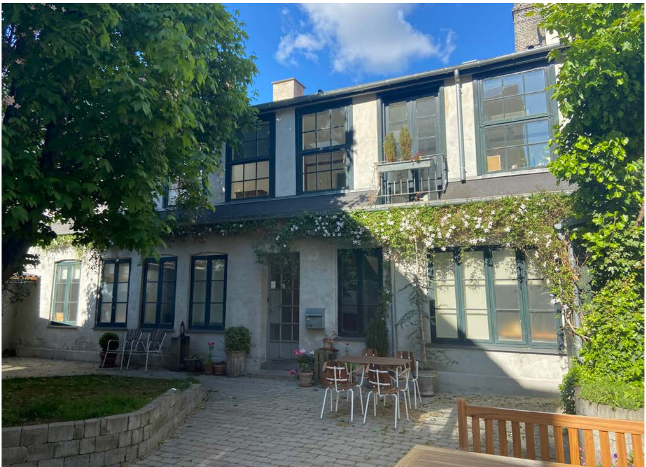
Figur 7. Eksempel på baghus med originale grønmalede vinduer, der afspejler bygningens anvendelse til erhverv
