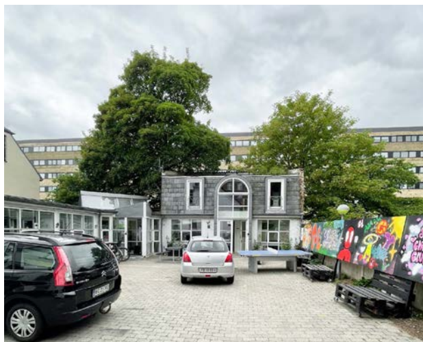
Nordre Fasanvej 99. Eksisterende baghus og mellembbygningen
