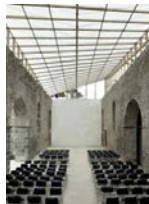
Baros Church, BROWMMENSES Tagkonstruktion afviger i udtryk og materialevalg i forhold til det eksisterende murværk. Vi forestiller os et glastag i aluminium, der giver mulighed for et let udtryk med spinkle profiler, som modspil til det massive eksisterende murværk.
