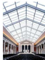
Glyptoteket Med taget udformet som et rytterhjul med en central kiplinje skabes balance i rummet. Vi ønsker at tilføje dette element i det nye glastag. Kiplinen giver desuden mulighed for oplukkelige felter i taget.
