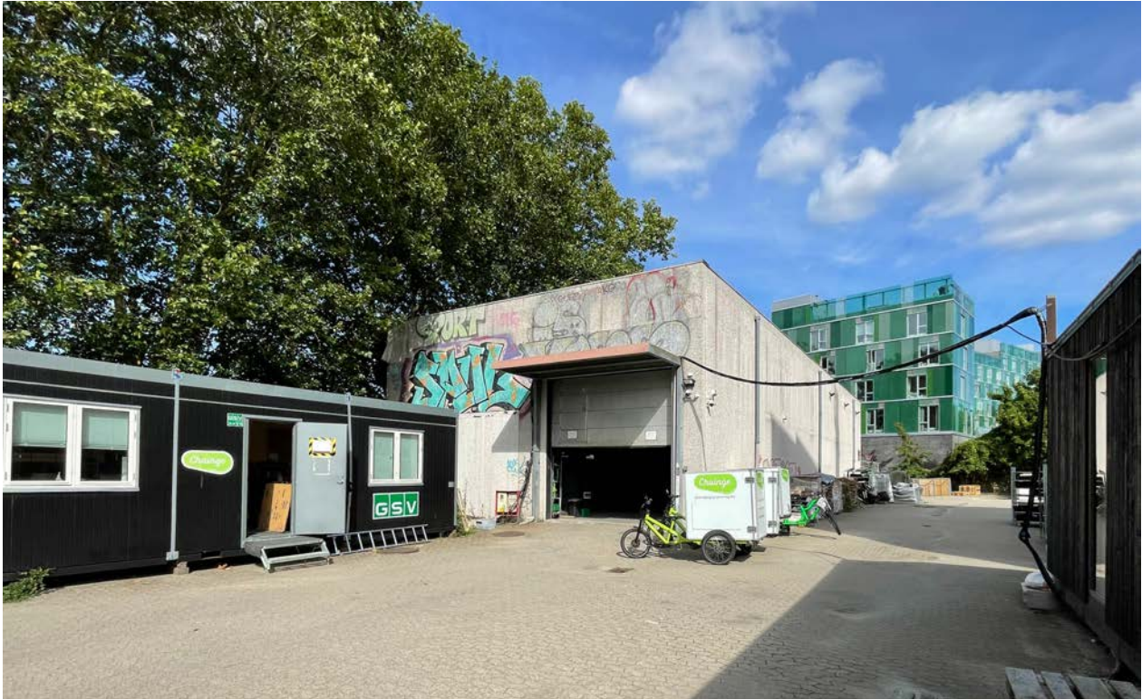
Eksisterende lagerbygning Fuglebakkevej 94.
