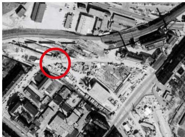
Matriklen i 1972 med den nu rørlagte å
