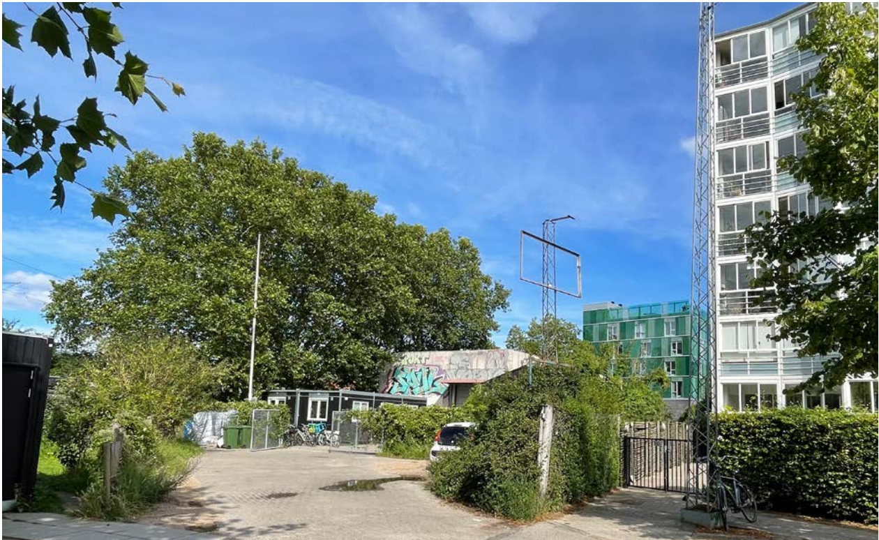
FØR: Eksisterende lagerbygning Fuglebakkevej 94 set fra Fuglebakkevej. Til højre i billedet ses boligetageejendommen Fuglebakkevej 92 og i baggrunden ses Engbakken/Falckhuset Nordre Fasanvej 207 - 209.
