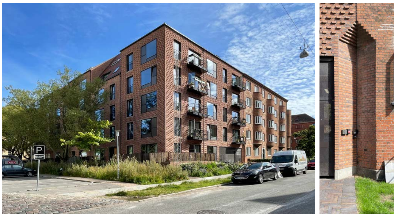
Etageboligbebyggelse Fuglebakkevej 88. Respektfuld arkitektonisk indpasning i eksisterende bebyggelsesstruktur, der i 2023 modtog Frederiksberg Kommunes bygningspræmiering. Foto: Frederiksberg Kommune.
