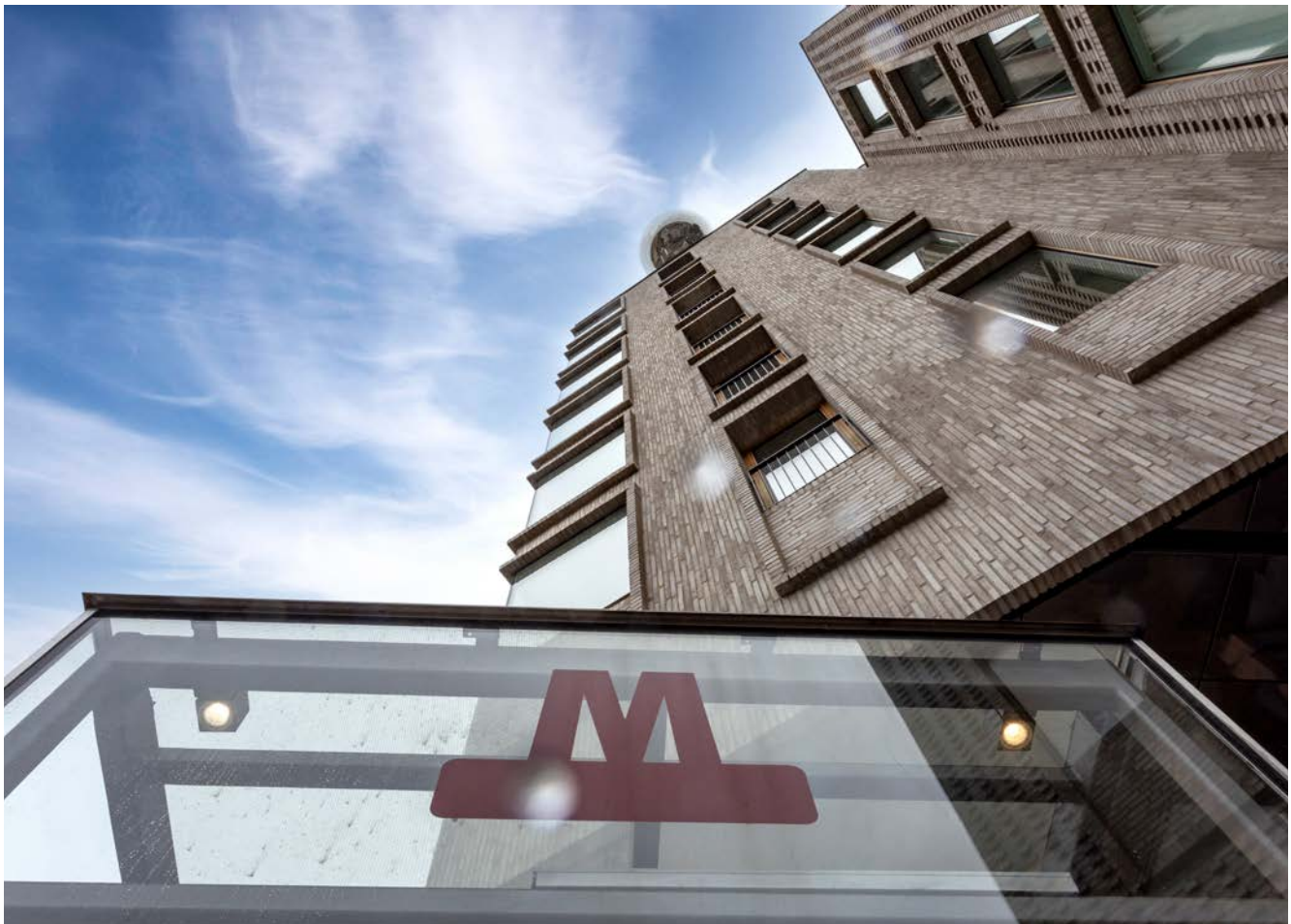
Frederiksberg Allé 41. På bygningens tag er kunstværket 'Balance of time' installeret. Foto: Dan Møller.
