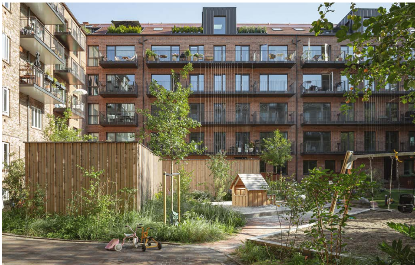
I forbindelse med opførelse af ny boligbebyggelse på Fuglebakkevej 88, er der etableret fælles nyt gårdanlæg for alle ejendomme i karréen. Foto: Yulia Kozlova.
