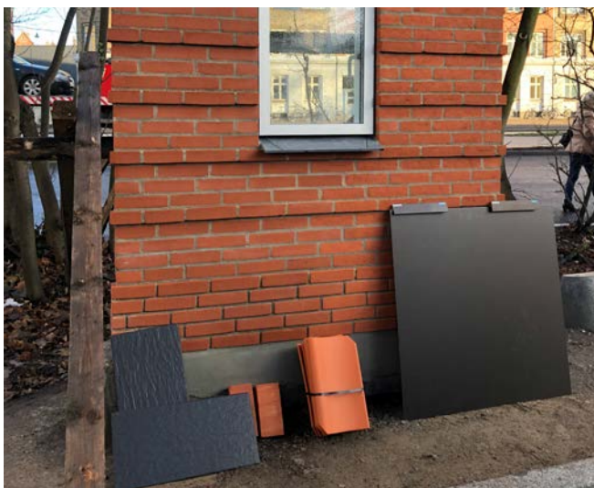
Eksempler på mock-up og drøftelse af facadematerialer i forbindelse med en byggesag, som medvirker til at sikre at lokalplanen bestemmelser overholdes 1:1. Fotos. Frederiksberg Kommune.
