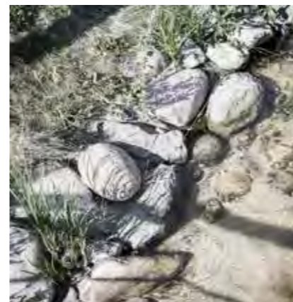
Søbredden ved Andedammens vest-side gøres naturlig med stensætning
