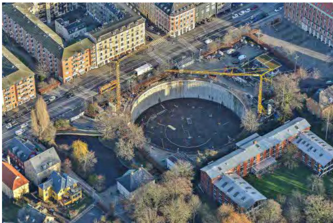
luftfoto af det eksisterende byggeri med anlæggelse af parkeringskælder
