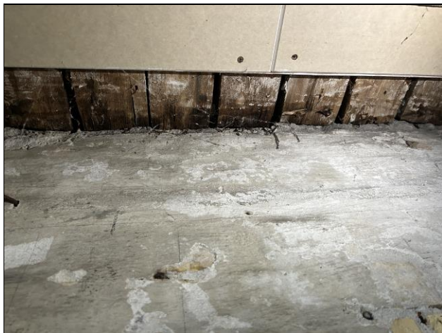
Foto 5 – Trækonstruktion ml kælder og stue er under nedbrud
