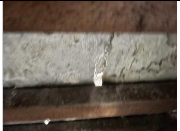
Foto 2 – En del revnede skiferplader mod det fri
