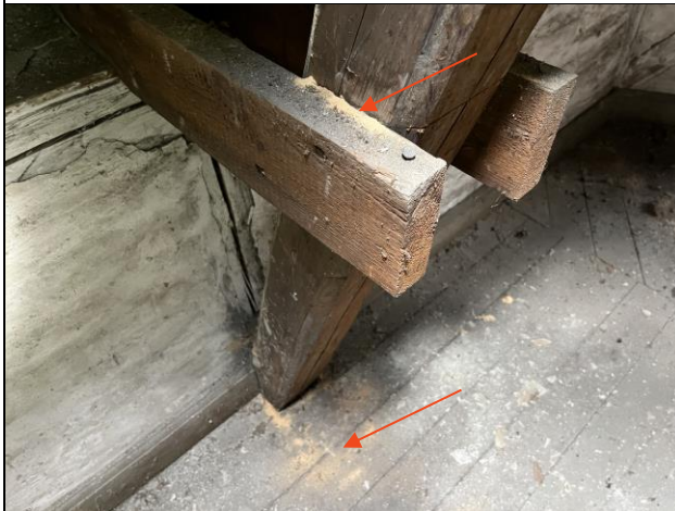
Foto 3 –Angreb fra borebiller. Markeringer angiver støv efter angreb
