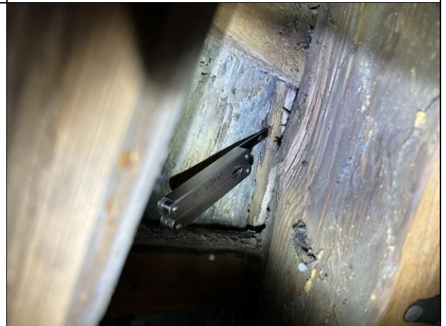
Foto 4 – Nedbrudt træmateriale
