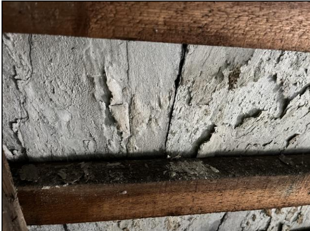
Foto 1 – Skiferpladerne nedslidte
