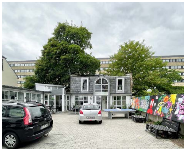
Nordre Fasanvej 99. Eksisterende baghus og mellembbygningen
