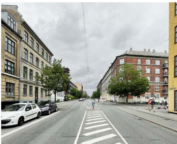
Nordre Fasanvej/Holger Danskes Vej set mod Borups Allé. Den eksisterende erhvervsejendom ses i venstre side bag vejtræet
