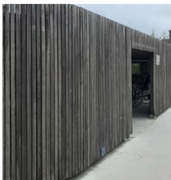
Eksempel på beklædning med trælameller
