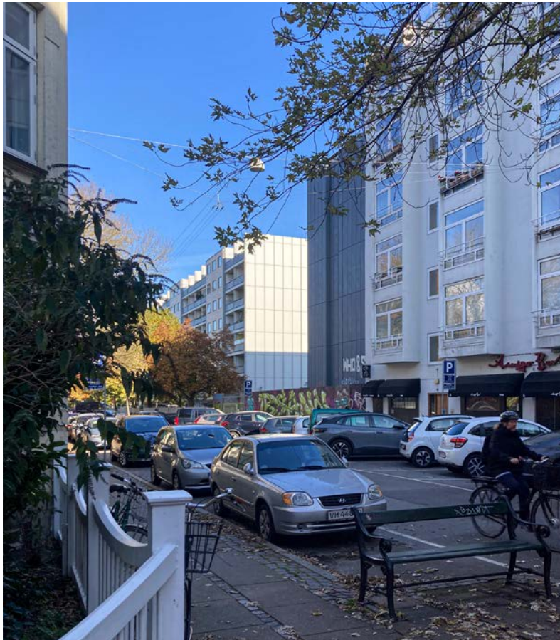
Eksisterende forhold set fra Gammel Kongevej op ad Schönbergsgade
