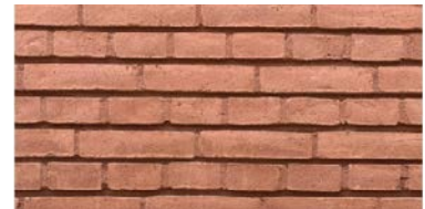
Illustration F: Facader i blødstrogne røde teglsten med fuger i samme nuance
