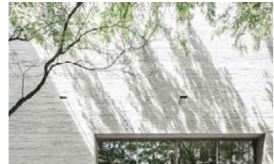
Illustration G: Facade i lysegrå blødstrogne fildede teglsten med fuger i samme nuance
