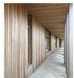
Træliste beklædning og beton søjler i kolonnade
