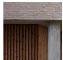
Materiale reference Teglfacade, beton søjle og træliste beklædning
