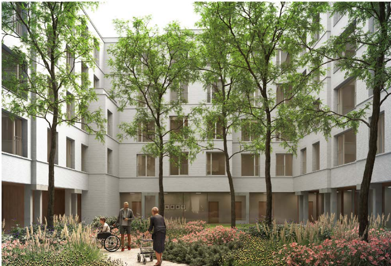
Visualisering af plejecentrets indre gårdrum, med en frodig grøn have og lysåbne træer. Facader i lys teglsten, filtset i en lys puds i varm tone. En kolonnade langs gårdens periferi tilbyder beskyttet udeophold og et mere 'blødt' rum i form af en varm trælistebeklædning på væg og i loft.
