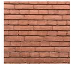
Mursten og fuger i samme røde nuance
