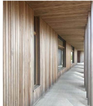
Illustration E: Trælistebeklædning på facade og loft i kolonnaderne
