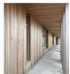
Træliste beklædning og beton søjler i kolonnade
