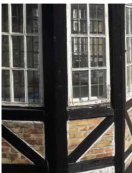
Bindingsværk på skolens hovedbygning, Tårnborgrvej 6-8
