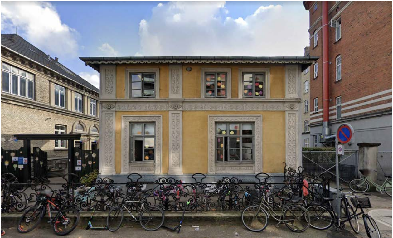
Eksisterende forhold - ornamenter på eksisterende bygning, Tårnborgevej 4
