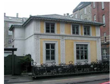
Billede af eksisterende bygning på Tårnborgevej 4
